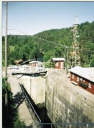
Brekke slussar i Haldenkanalen.
